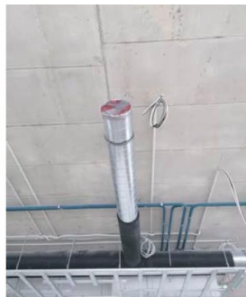
Pagaidu atvērumu blīvējumi mērījumu vajadzībām
