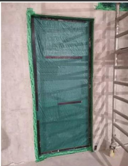
Pagaidu atvērumu blīvējumi mērījumu vajadzībām
