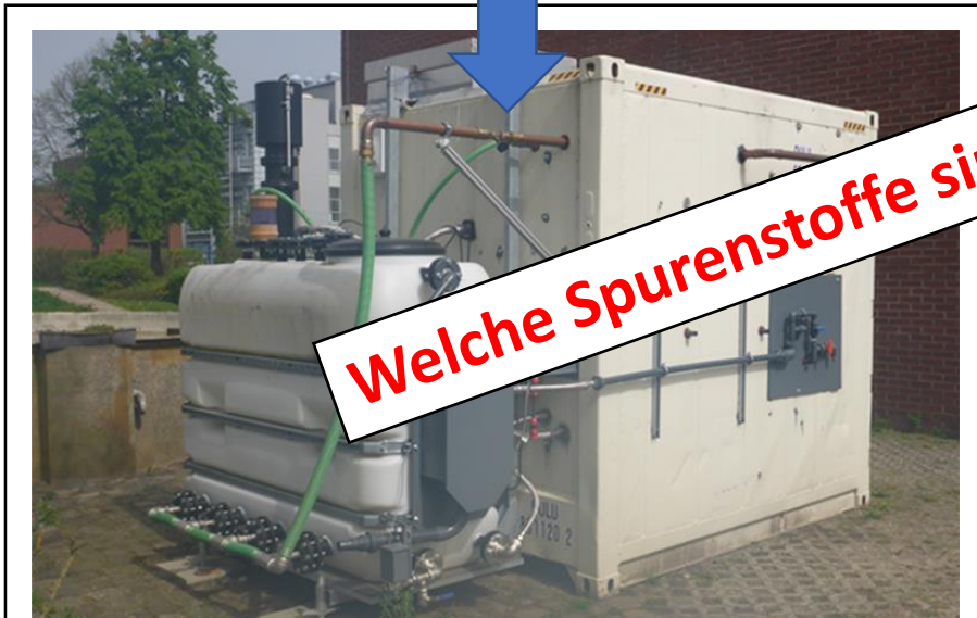
Bau & Programmierung des „großen“ Pilot-MBRs
