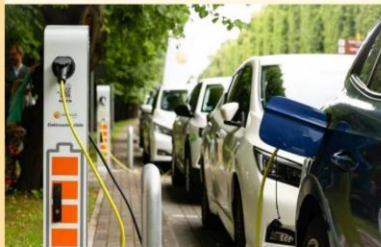
2. attēls. Autostāvvietā ar elektroauto uzlādes stacijām. Avots: esfond.lv
