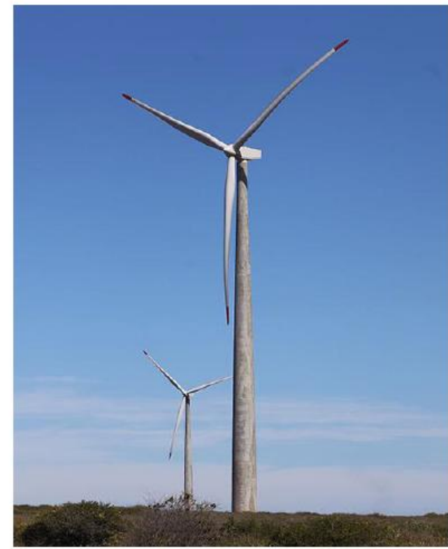
1 Attēlā turbīnas ar dzelzsbetona torni.
