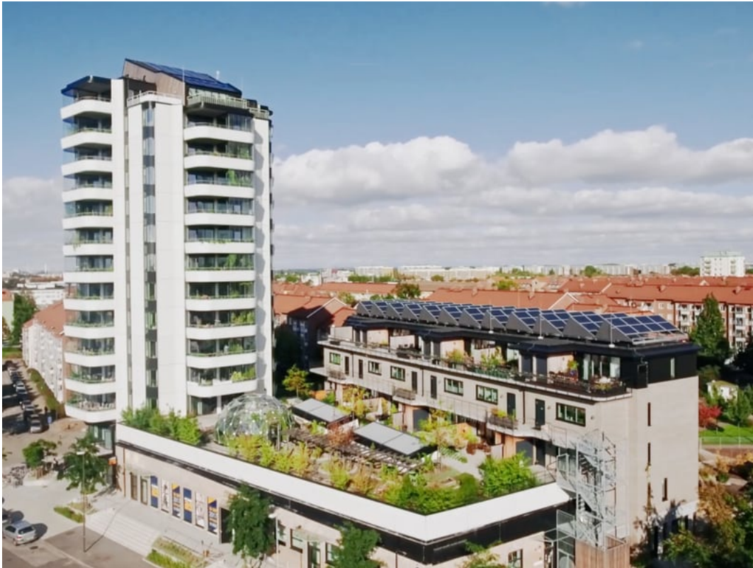
82. attēls. Augustenborg Greenhouse (avots: MKB Fastighets AB).
